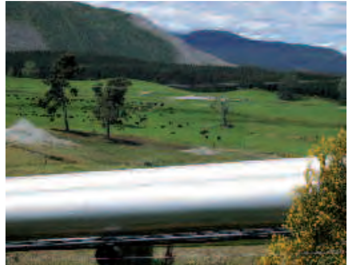
Planta geotérmica ciclo "flash" de Taupo-Mokai (Nueva Zelanda)
