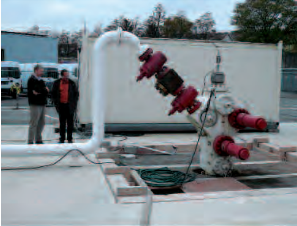
Cabeza del sondeo (5.000 m de profundidad) del Proyecto “Deep Heat Mining” en Basilea (Suiza)
