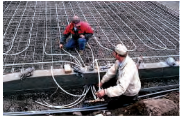
Instalación del sistema de tuberías para el sistema geotérmico de calefacción de distrito para deshacer la nieve de las aceras. Oregon. Fuente: National Renewable Energy Laboratory
