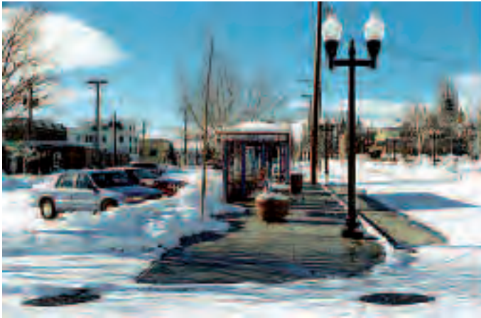
Sistemas de calefacción de distrito para deshacer la nieve de las aceras. Oregon. Fuente: National Renewable Energy Laboratory
