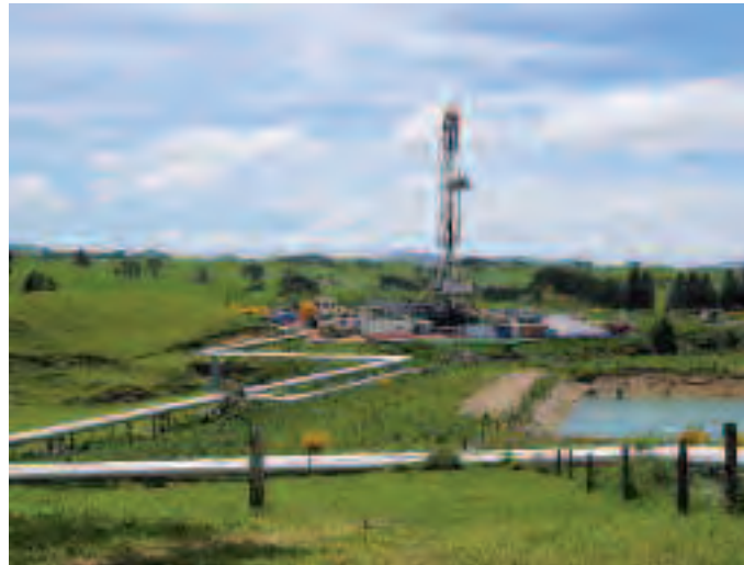
Perforación en central geotérmica de Mokai (Nueva Zelanda)
